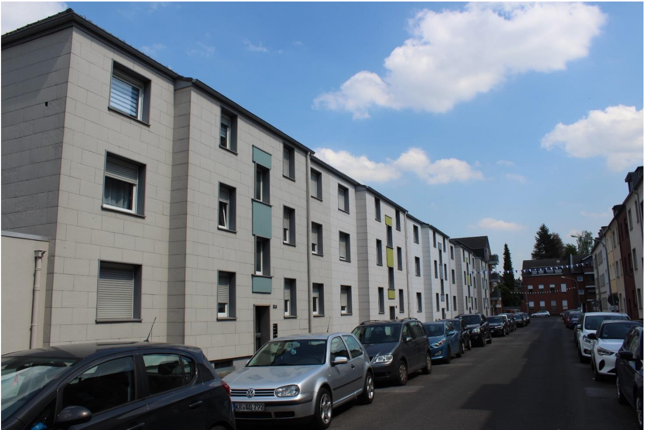
Hittastraße 19-27, Knopsstraße 20-28 (Baujahr 1951)
