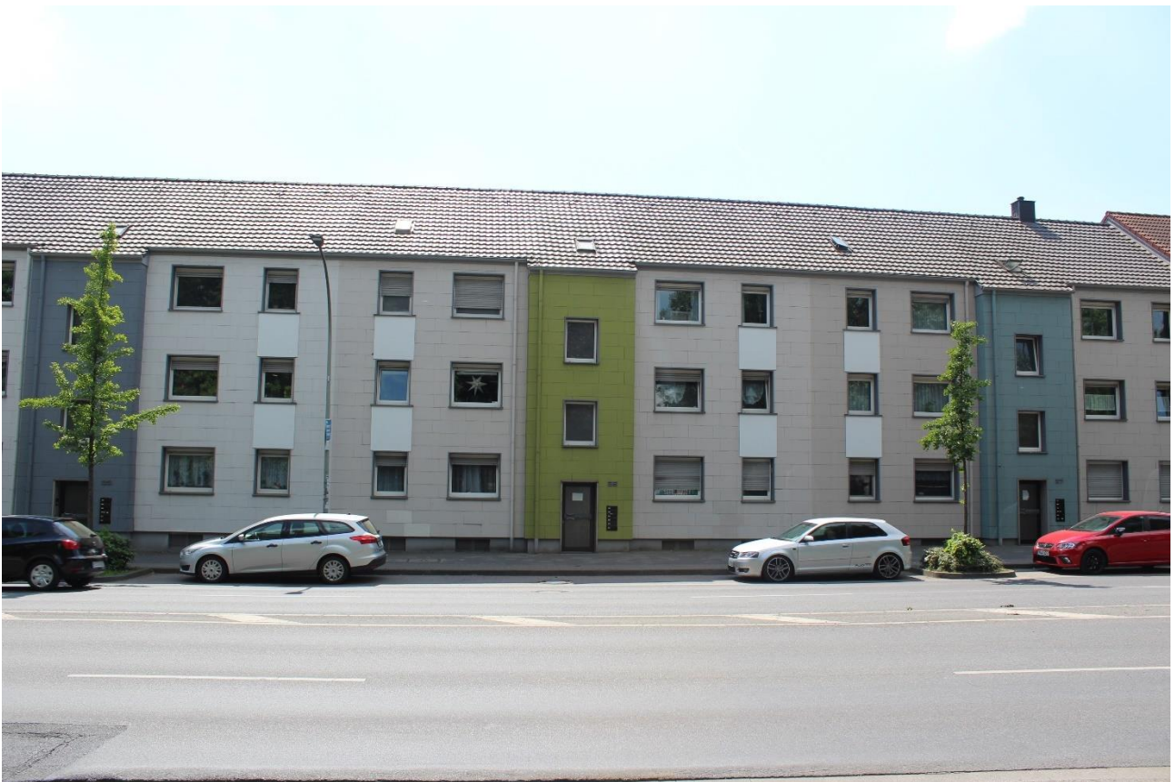
Hittastraße 19-27, Knopsstraße 20-28 (Baujahr 1951)
