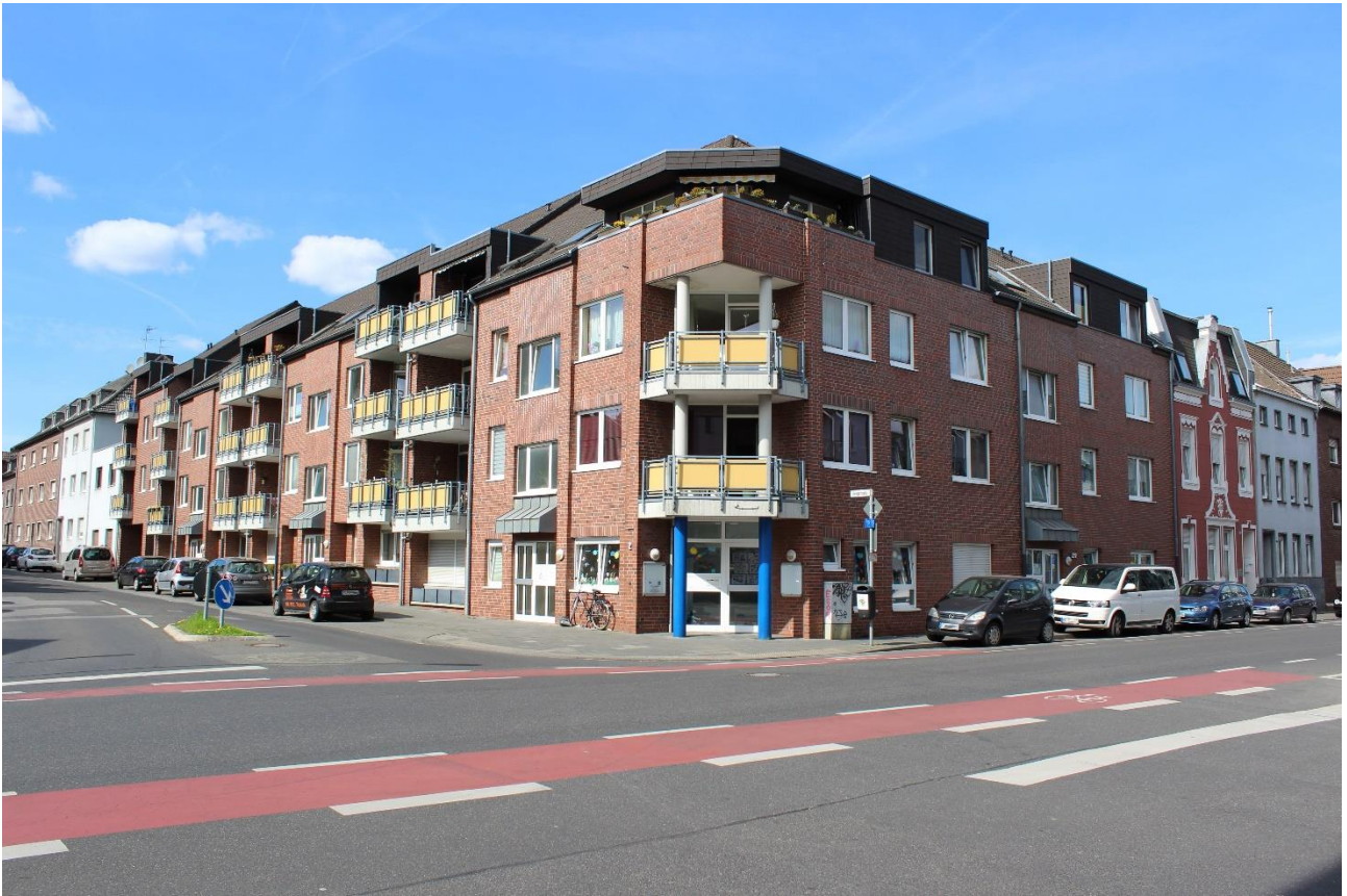
Bergstraße 2-10 / Eickener Straße 299 (Baujahr 1997)
